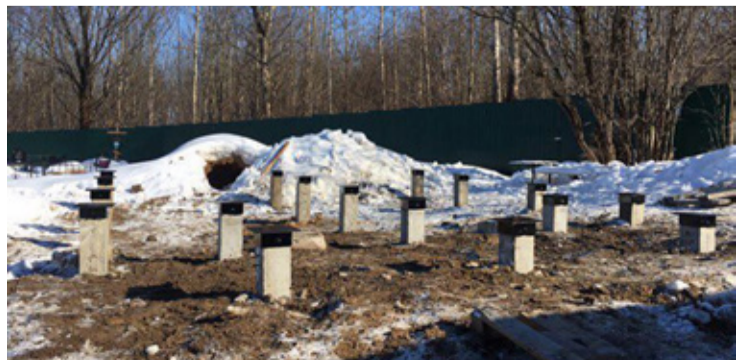
Начало строительства, 2018 г.
